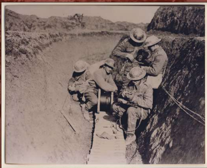
Les signaleurs canadiens réparent le câble dans une tranchée de communication, en février 1918. MIKAN 3405811
